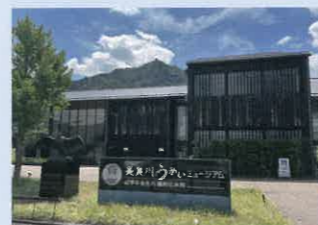
長良川かいミュージアム(岐阜市長良川磯崎伝承館)
